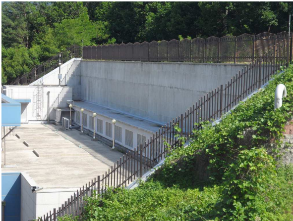
옹벽 상단 전경
