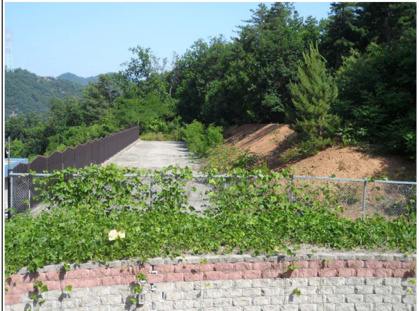
상부 성토부 전경
